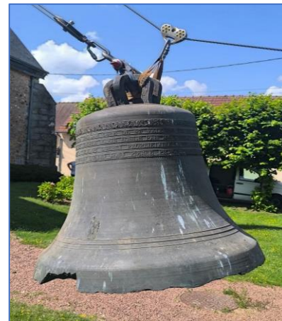
Dépose de la cloche abimée
